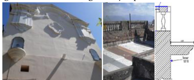
Fig. 11. Elementos no estructurales: cornisas, parapetos, balcones.
