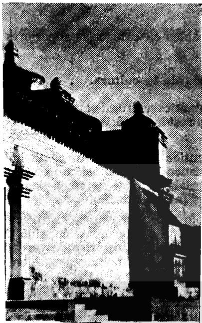
IGLESIA DE PANCHIMALCO. — Fragmento del muro occidental. Ob- sérvese cómo el muro de la fachada rebasá ampliamente la altura del templo.
