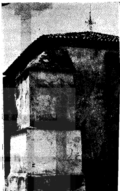
IGLESIA DE PANCHIMALCO.—Contrafuerte de ángulo en la cabecera.
